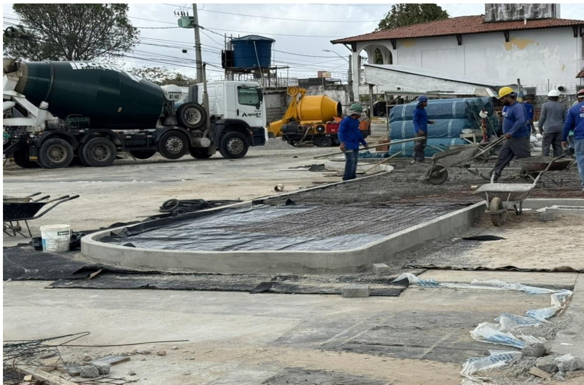
Figura 14. Execução de meio-fio..
