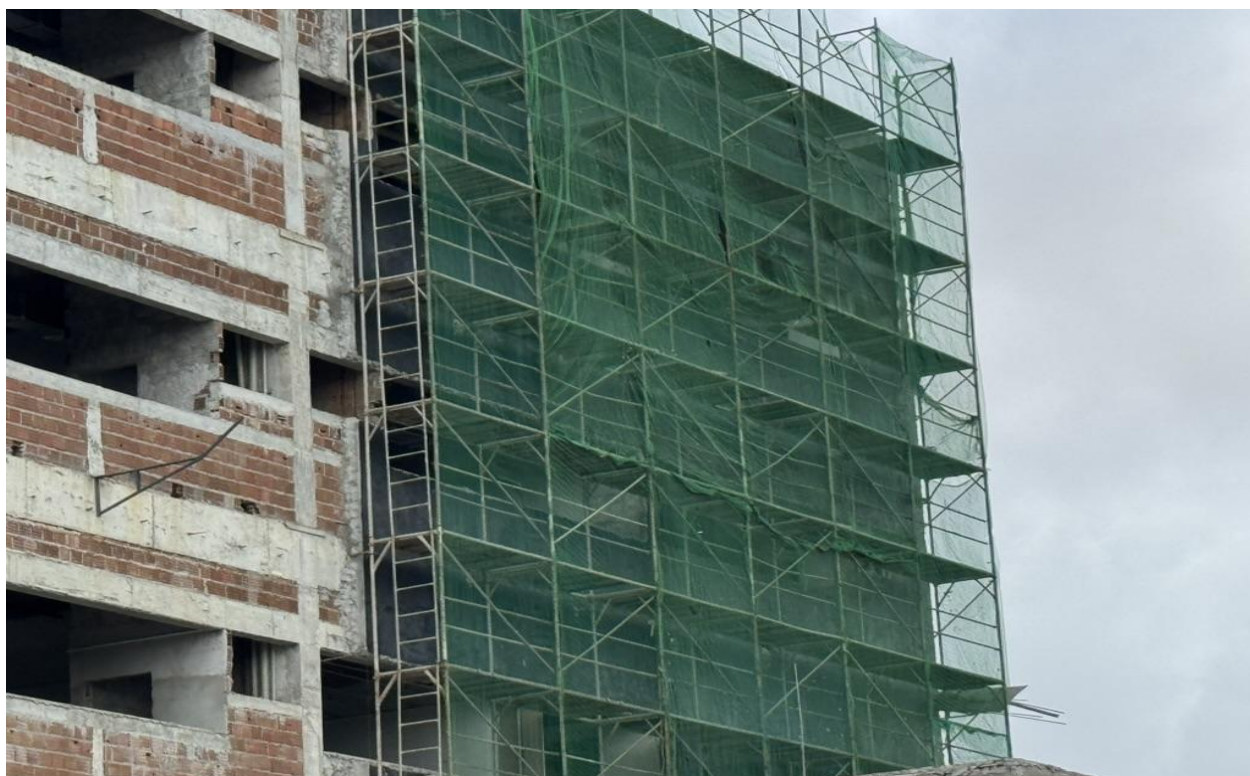
Figura 21. Execução de Manta têxtil drenante, Macdrain.
