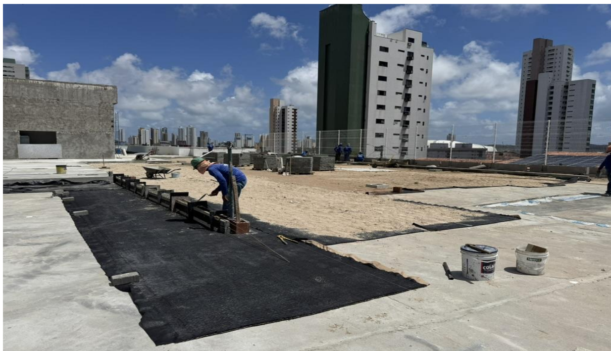
Figura 19. Execução de Manta têxtil drenante, Macdrain.
