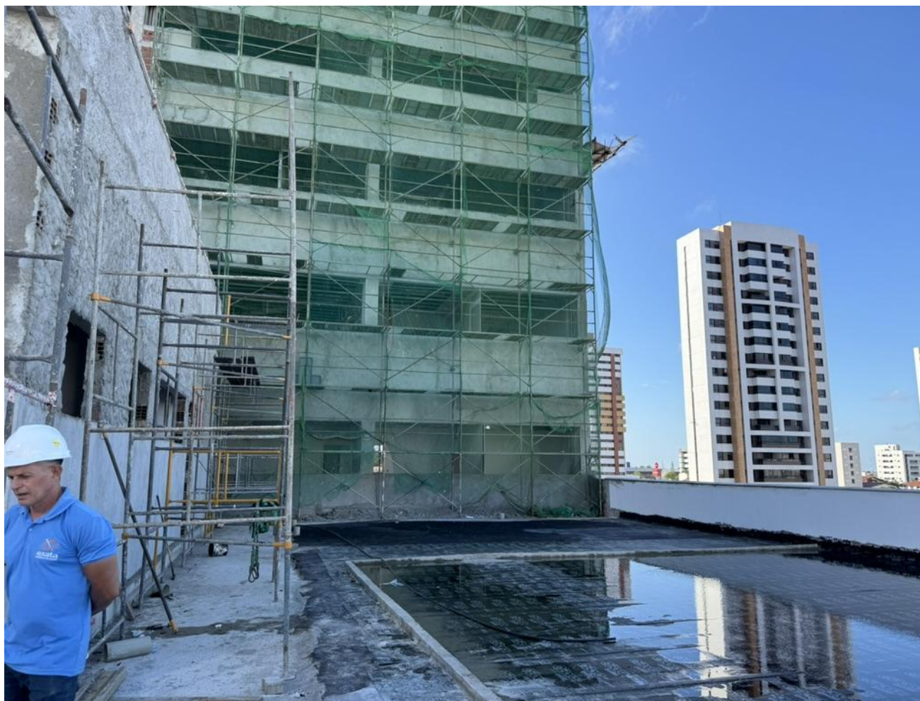
Figura 18. Execução de manta dupla na laje do térreo, teste de estanqueidade.
