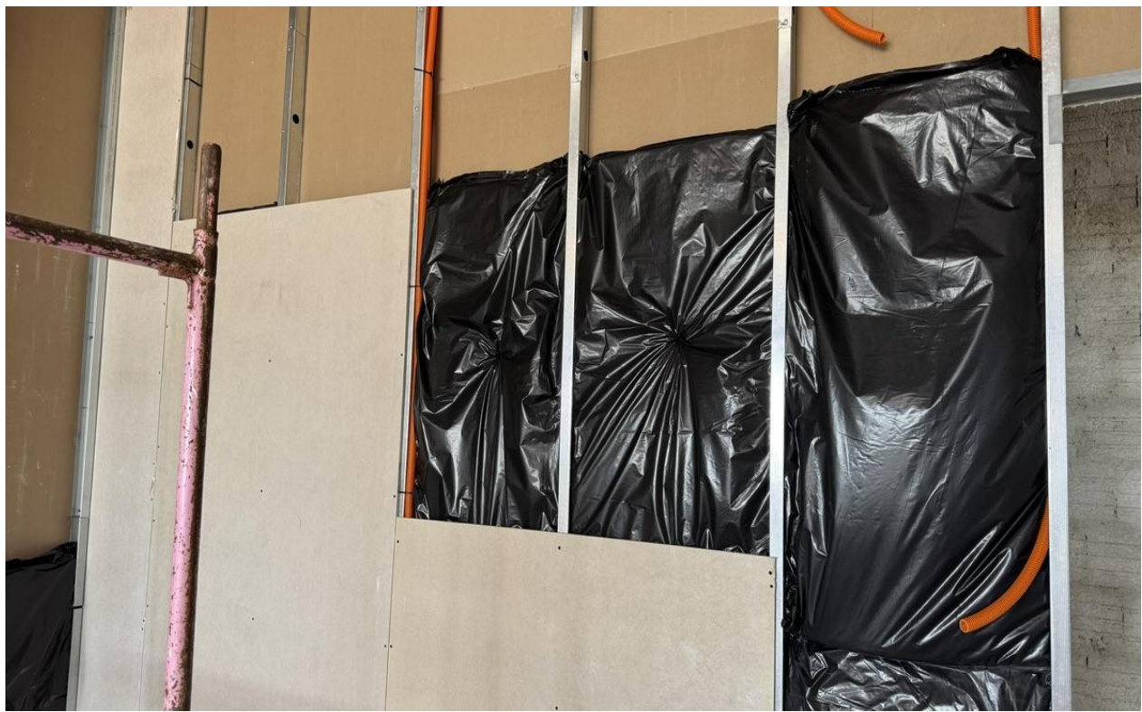
Figura 4. Instalação de lâ de rocha em paredes Drywall no 1º pavimento.
