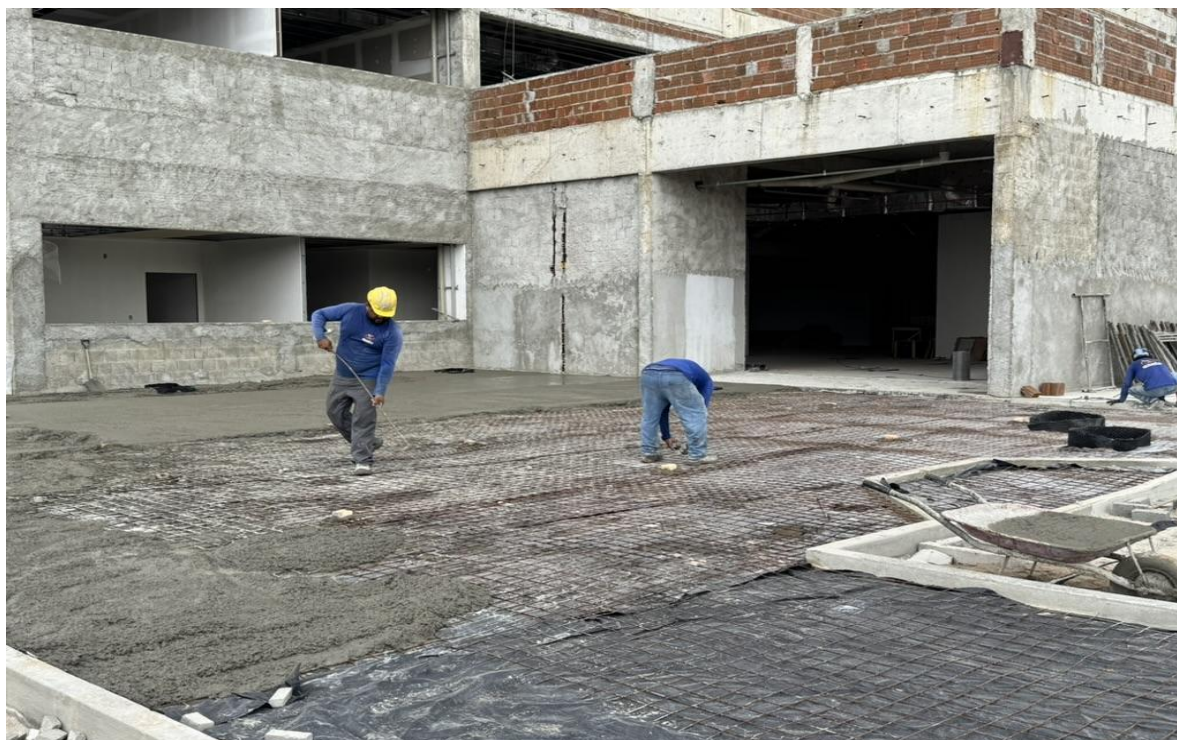
Figura 15. Concretagem da calçada e piso cimentado na entrada do prédio.
