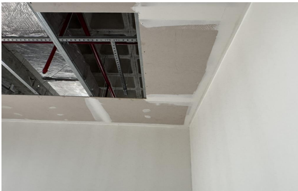
Figura 11. Execução de forro em drywall no pavimento térreo.
