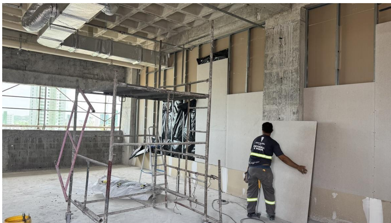
Figura 3. Instalação de paredes Drywall no 1o pavimento.
