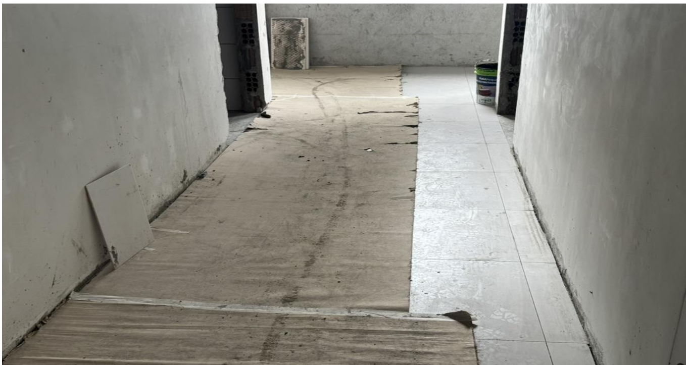
Figura 7. Inalação do piso no corredor de acesso aos banheiros acessíveis do 2o pavimento.
